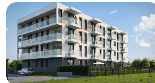
Widok od strony ulicy
