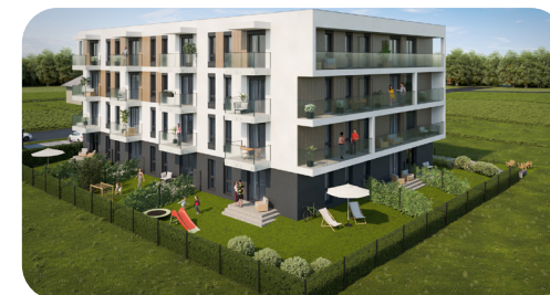
Widok od strony ogrodów
