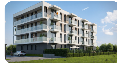
Widok od strony ulicy
