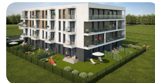
Widok od strony ogrodów
